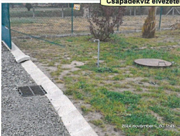
Csatorna tisztítódombok
