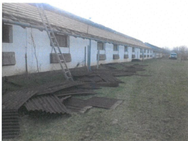
A tetőhéjalás lebontása
