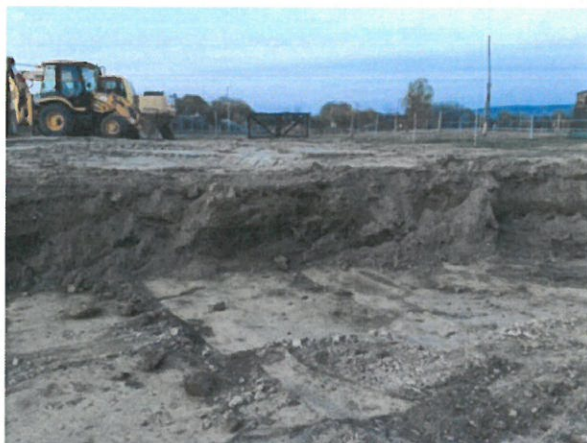
2022-ben épített közmű
