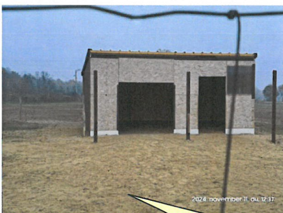
OSB szerkezetű istálló
