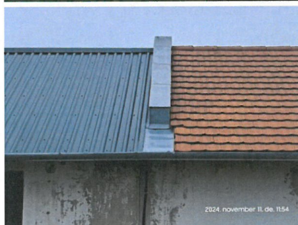
Az épület tetőszerkezete részben cserépfedéssel, részben acéllemezzel borított
