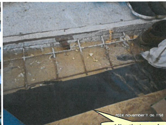
Aljzatbetonozás
