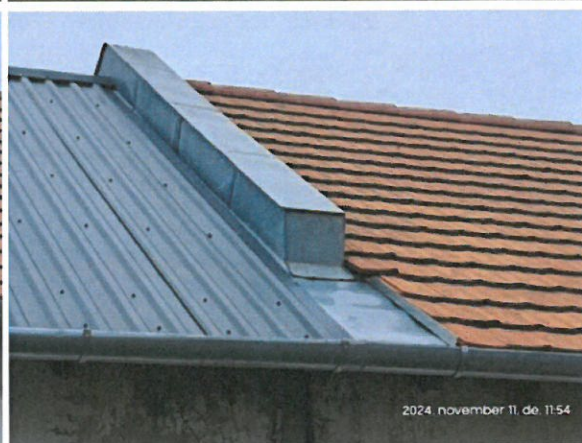
Az épület tetőszerkezete részben cserépfedéssel, részben acéllemezzel borított
