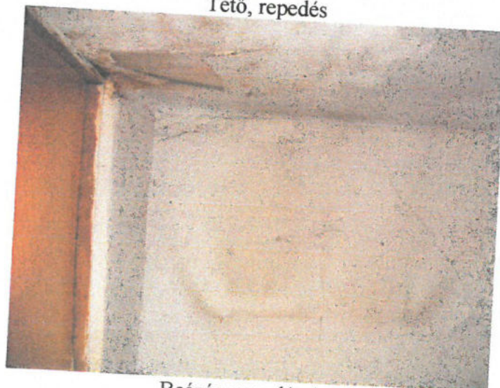
Beázás, repedések
