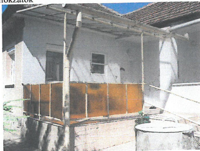
Fedett terasz, bejárat az épületbe
