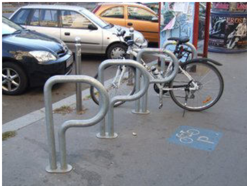
8. Fotó: P alakú kerékpártámaszok horganyzott acélból
