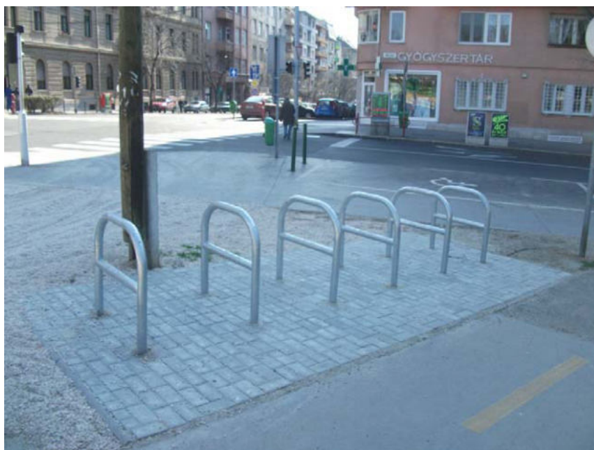
9. Fotó: U alakú kerékpártámaszok horganyzott acélból
