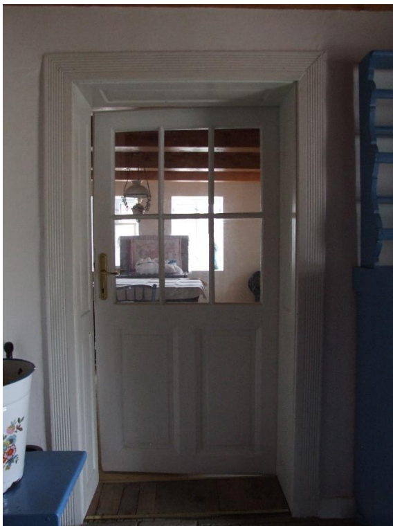
23. kép: Belső, béletes üvegezett váztaáblás fa ajtó (2021. január)
