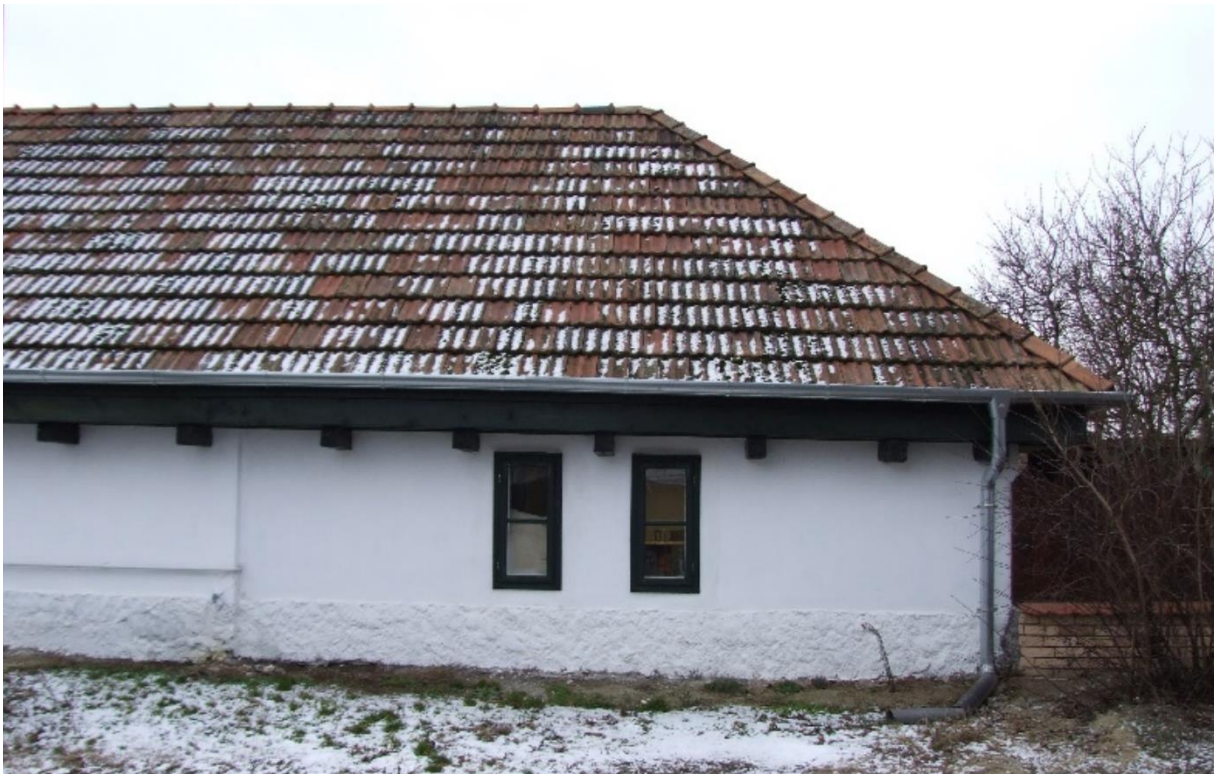
15. kép: A Huszai utcai homlokzat ablakai (2021. január)
