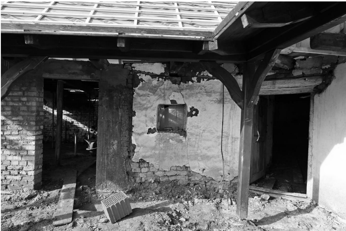
6. kép: A hátsó szárny a felújítás kezdetén
