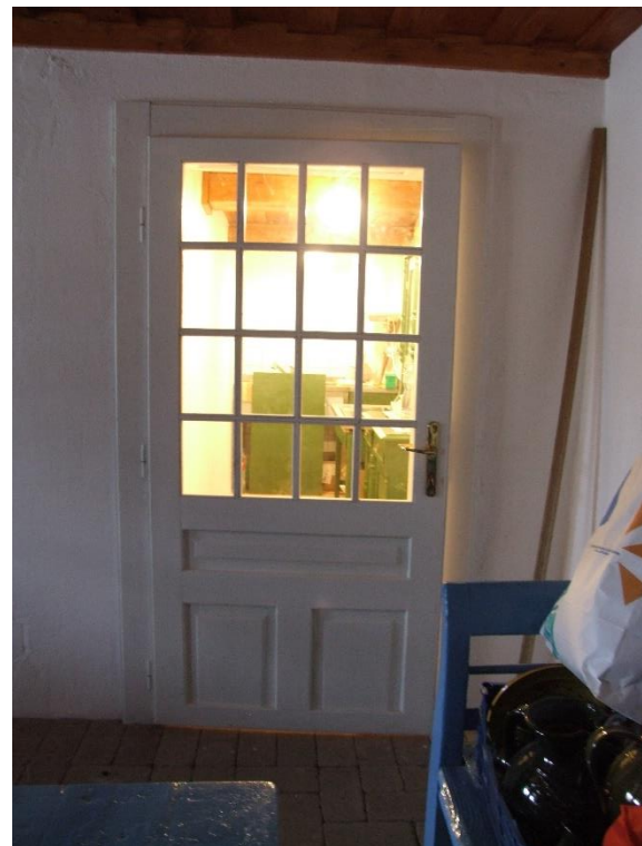
24. kép: Belső, béletes üvegezett váztaáblás fa ajtó (2021. január)
