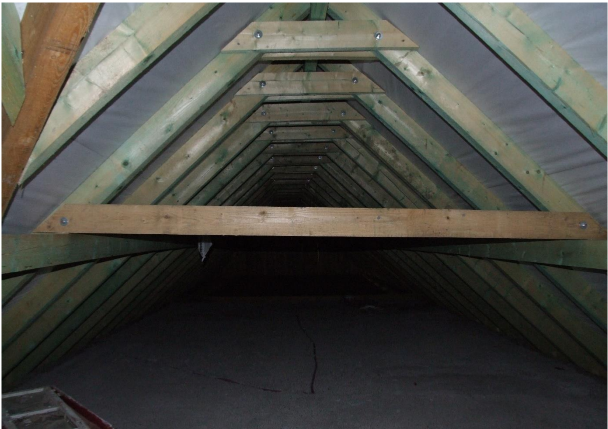
20. kép: Az új fogópáros fedélszerkezet (2021. január)
