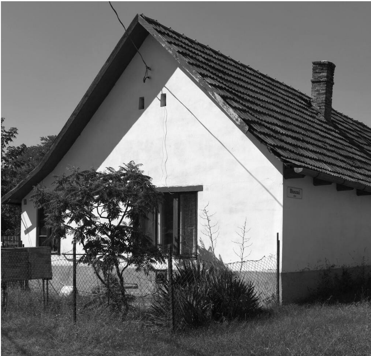
4. kép: Az utcai homlokzat a felújítás előtt
