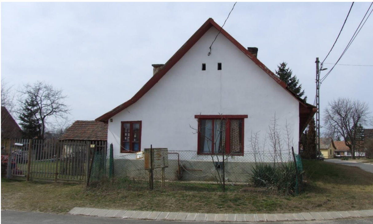
2. kép: Luther utca 2., utcai homlokzat (2016. március)
