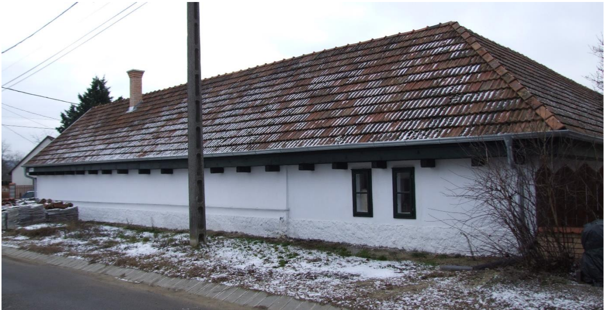
9. kép: Északi, Huszai utcai homlokzat (2021. január)
