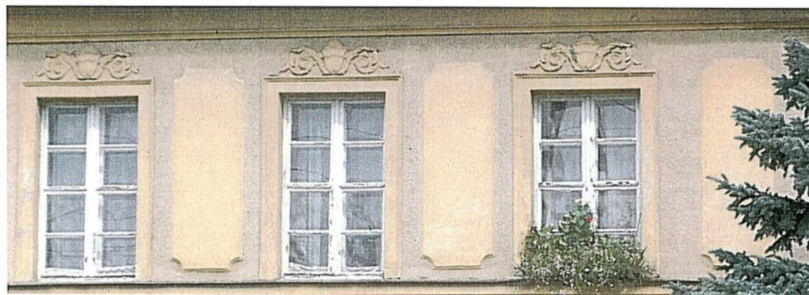
3. kép: A középrizalit emeleti ablakai a vágányok felől
