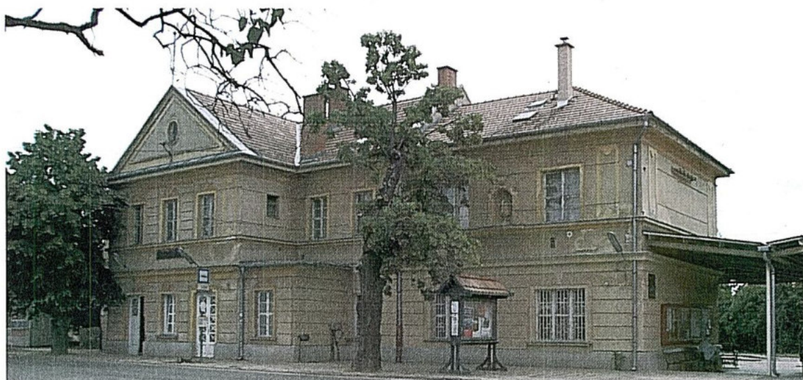
2. kép: A felvételi épület utcai homlokzata délnyugati irányból
