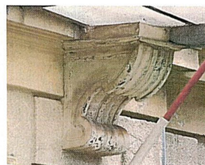
15. kép. Előtető konzolja
