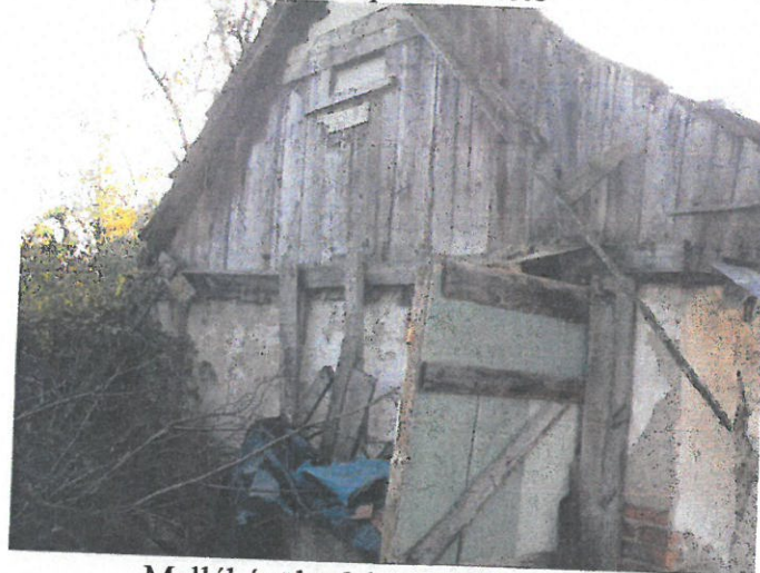
Melléképület 2 hátsó homlokzata
