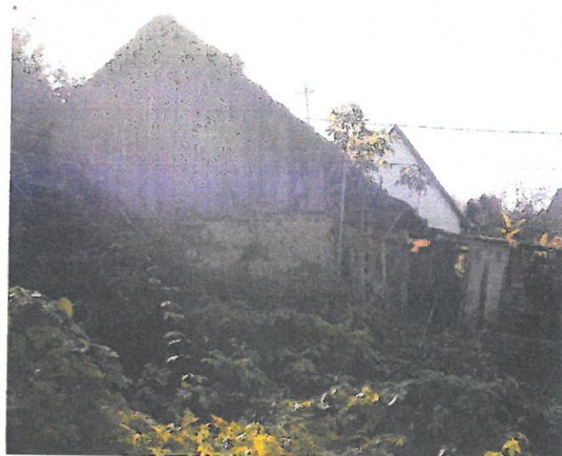
Melléképület 1 hátsó homlokzata
