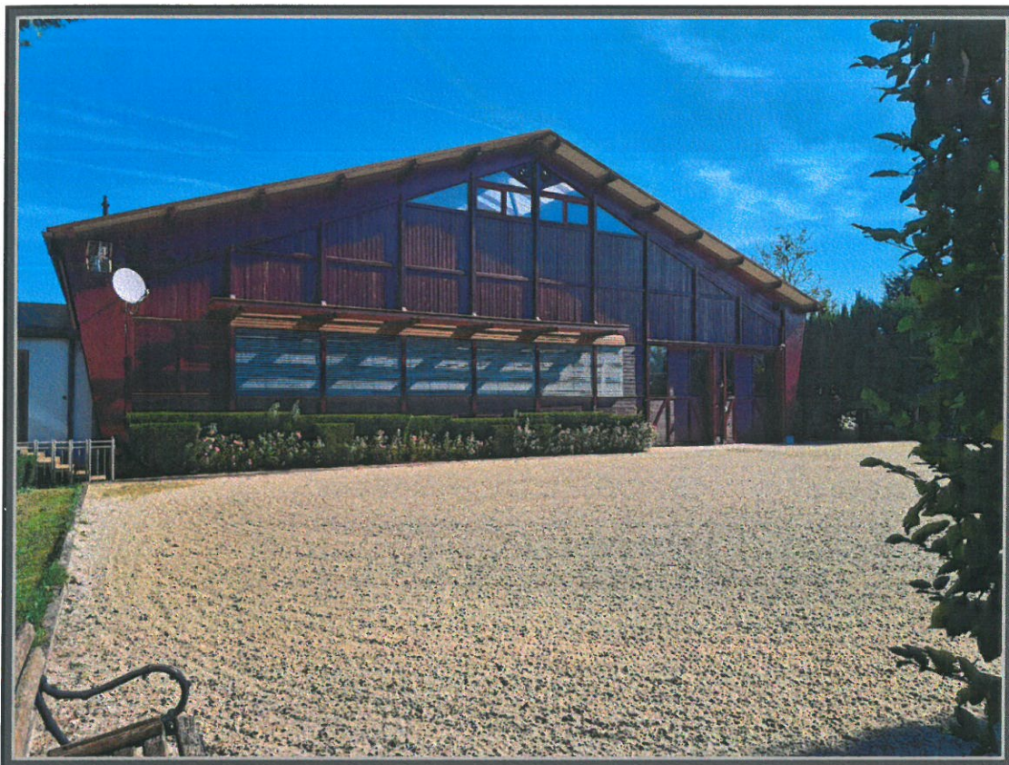
A nagy fesztávú, rétegtelt - ragasztott fa tartószerkezetű lovarda külső homlokzata.
