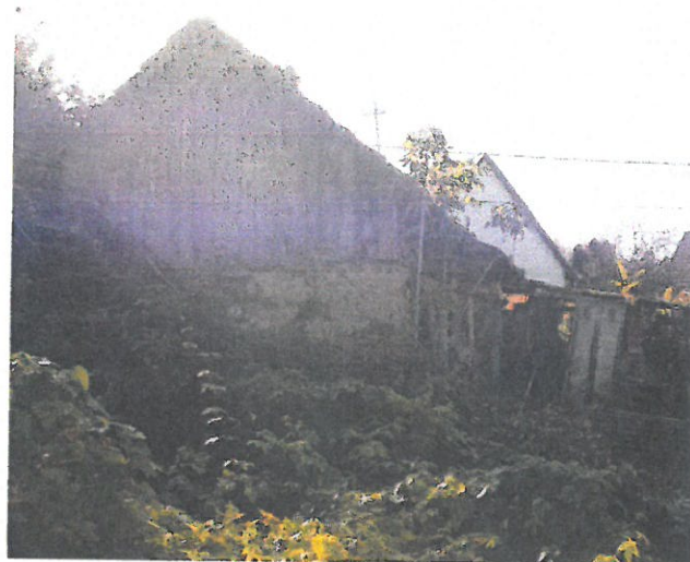
Melléképület 1 hátsó homlokzata
