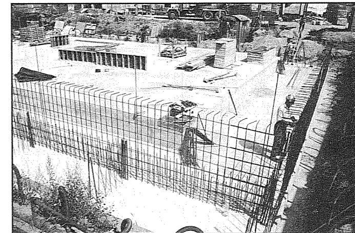
Épül már a sportcsarnok és az uszoda. Következő számunkban részletesen beszámolunk az építkezésről.
