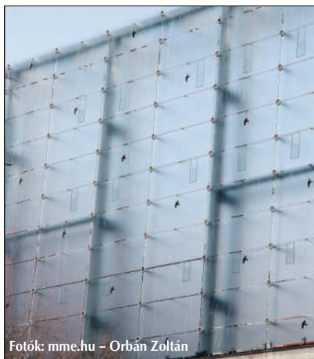
Veszélyes üvegfal „madárbiztosra” fóliázva
