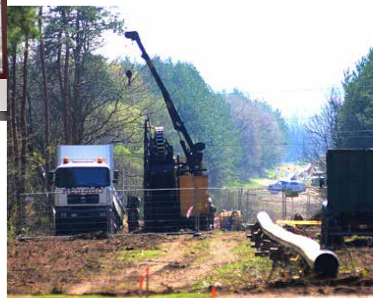
Átépítik a határban a Barátság Kőolajvezeték csőrendszerét
