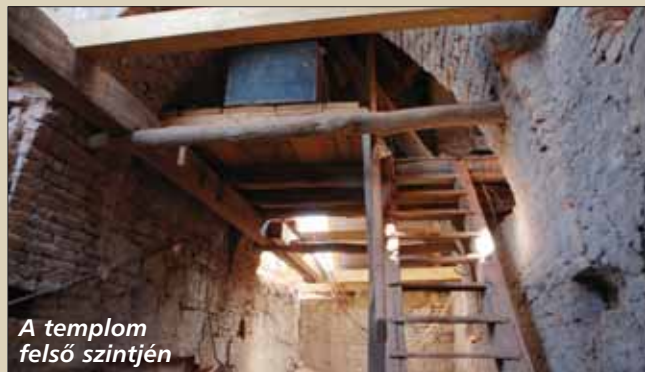
Az új tetőszerkezet
